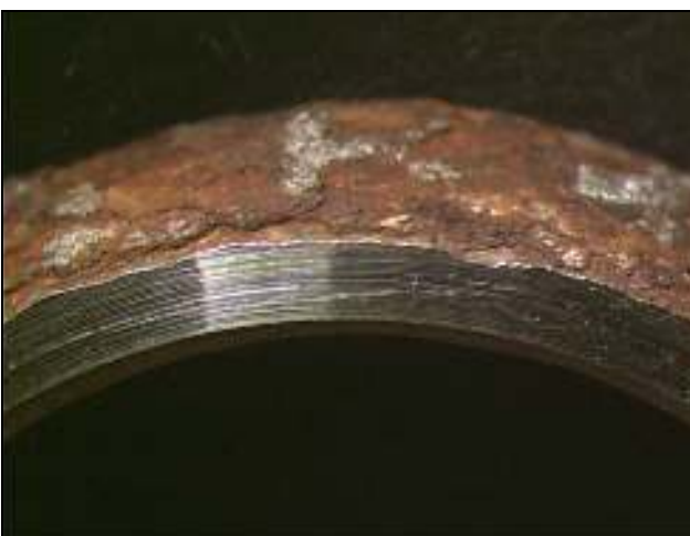
4. ábra. Korrózió a tűztéri oldalon Fig. 4: Corrosion on the fire box side
