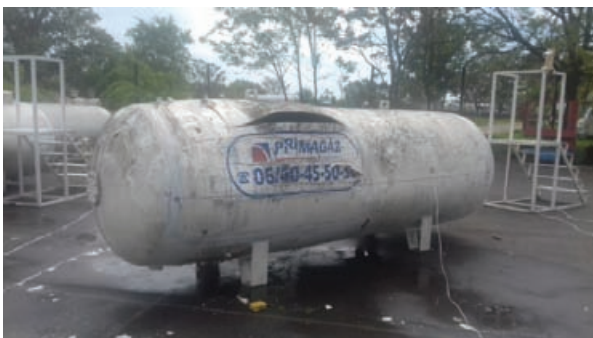
4. ábra: A II/1sz. tartály felszakadása (30608)
