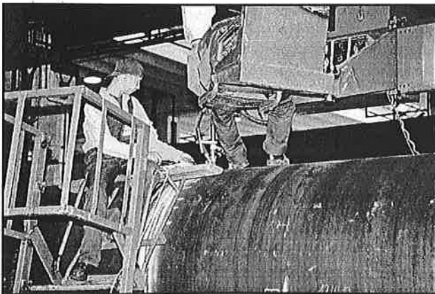
4. ábra. A körvarrat hegesztése és demagnetizálása
