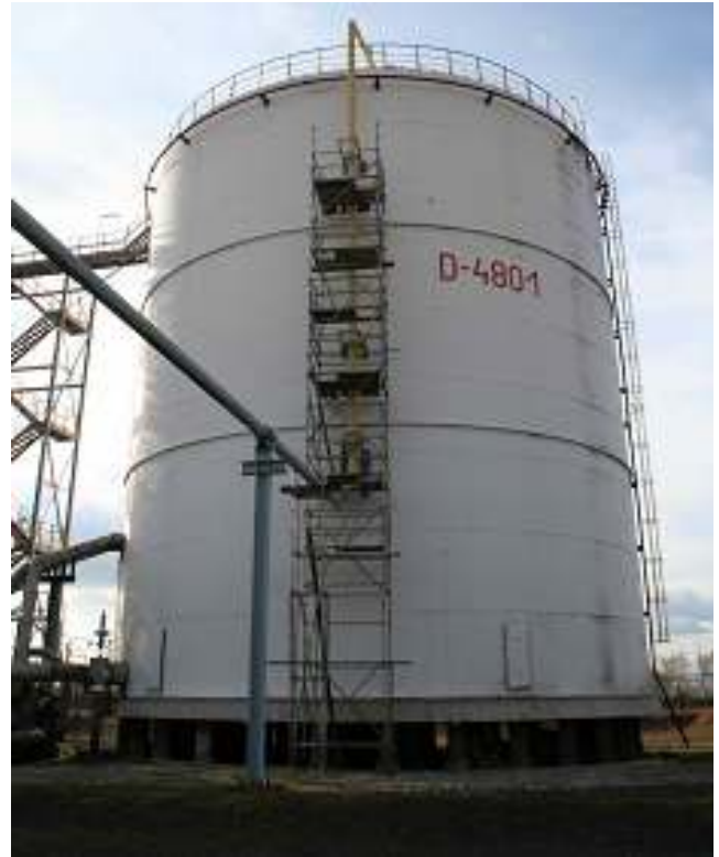
A tiszaújvárosi, 4724 m 3 -es, álló hengeres, kettős köpenyű tartály -104 °C-os folyékony etilén tárolásához
