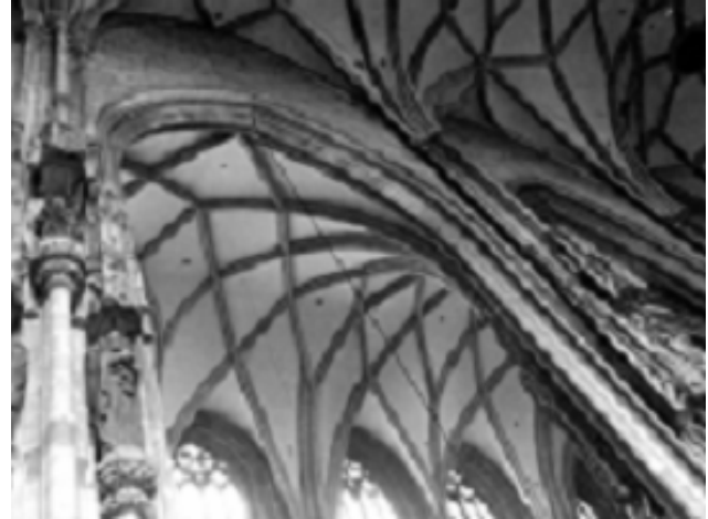
1. ábra. A bécsi Szent István templom kőből épült vázszerkezete; fotó: Bostenaru Mária, 2006 Fig. 1: Skeleton structures out of stone material: the Saint Stephen church in Vienna; Photo: Maria Bostenaru, 2006.
