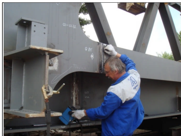
3. ábra Helyszíni roncsolásmentes anyagvizsgálat az épülő új Duna hídon Figure 3 NDT of the new Danube bridge part on site
